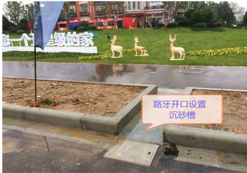
图 4-13 道路两侧路牙开口示意图
