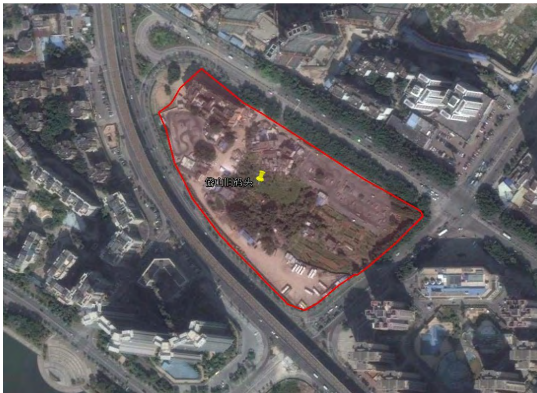
17 岱山旧码头村水浸黑点汇水范围
