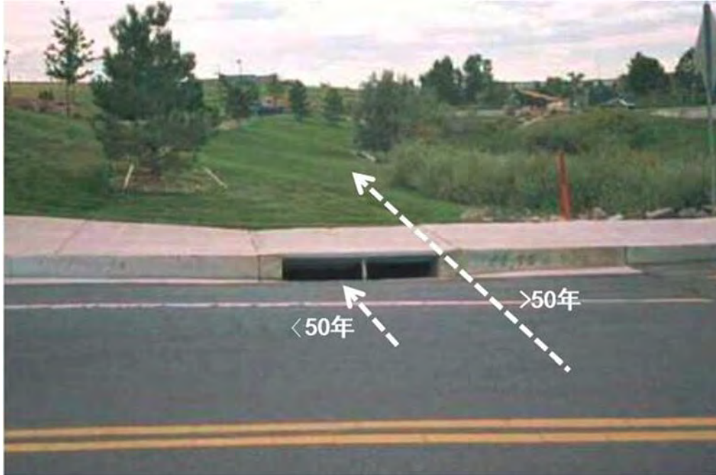
图 4-15 涝水泄流通道设计图
