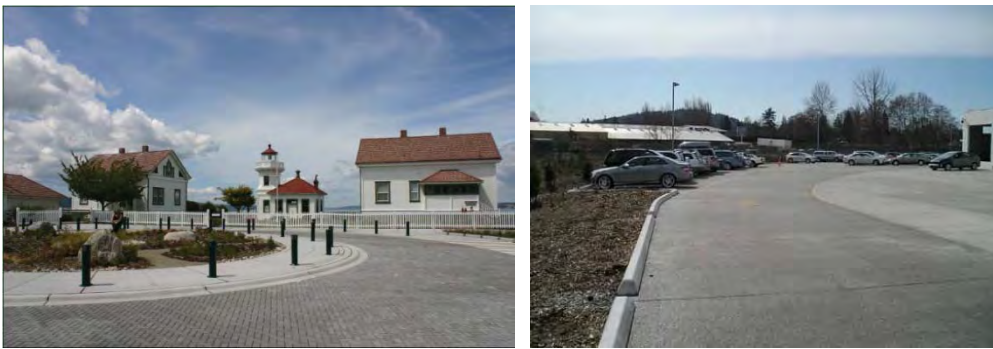
图6-2 透水铺装和透水路面
